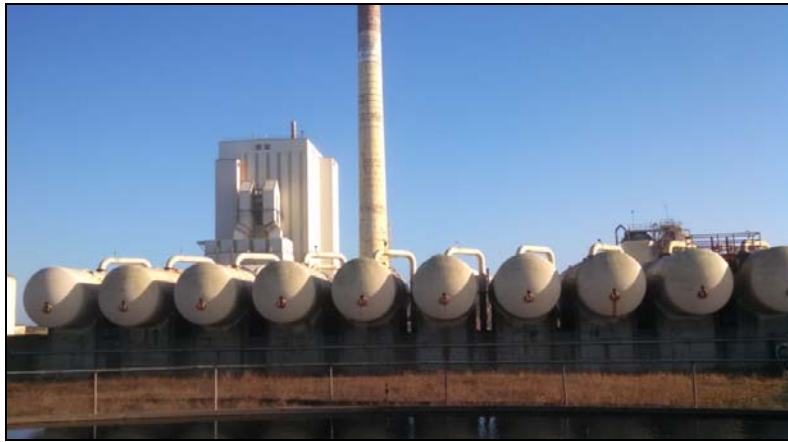
Photo 3: MicroFloc Filters
