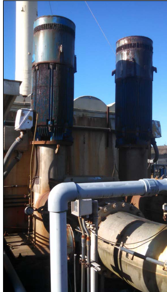
Photo 2: Effluent Pumps
